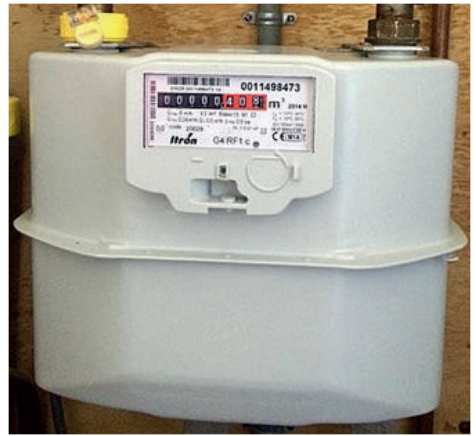
Nieuwe 'domme' gasmeter
