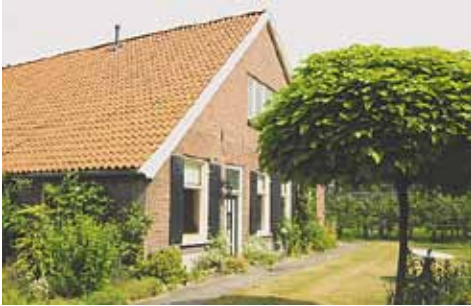
Fig. 5 Achteraanzicht van het gastenverblijf waar voordien de kabel langs liep, 1 meter uit de gevel.
