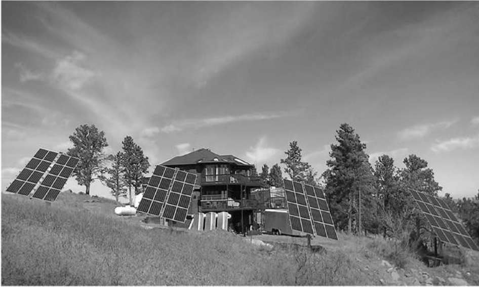
Installatie van zonnepanelen op de grond bij het huis kan een veiliger optie zijn dan installatie op het dak.
