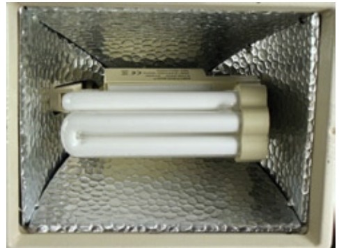
Fig.1. Spaarlamp in armatuur 24W, opgebouwd uit 3 units.
